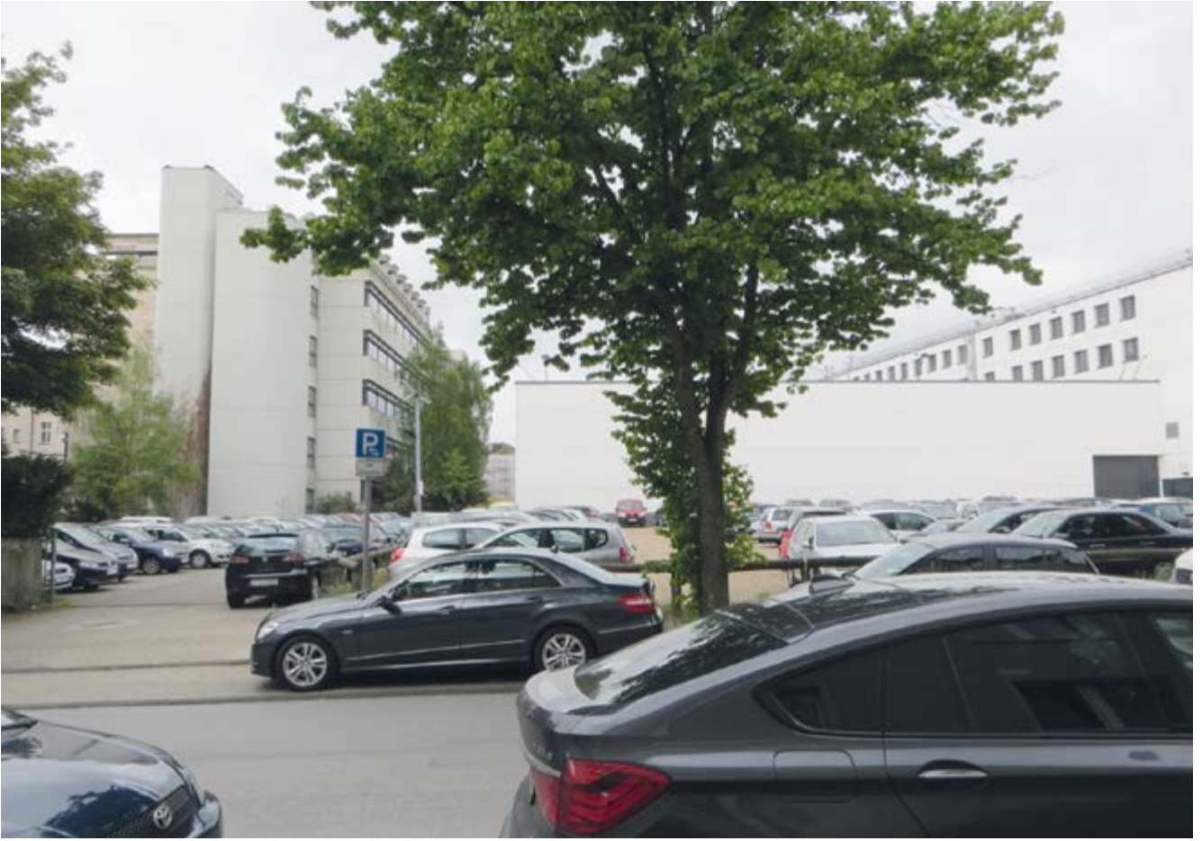
Außenansicht Alter Saaltrakt und JVA
