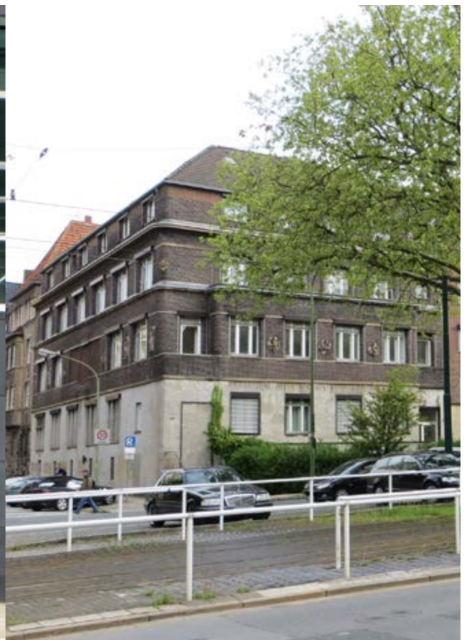
Außenansicht Staatsanwaltschaft (Altbau)
